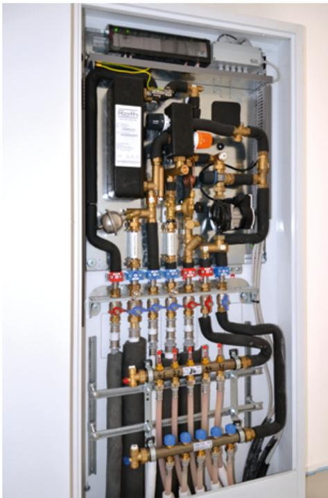
**Bild 3 • Das energieeffiziente Regelkonzept der Roth FlatConnect Wohnungsstation gewährleistet gleichmäßige Warmwassertemperaturen und konstante Zapfraten für höchsten Nutzerkomfort. (Foto: Kathrin Bühring)**
