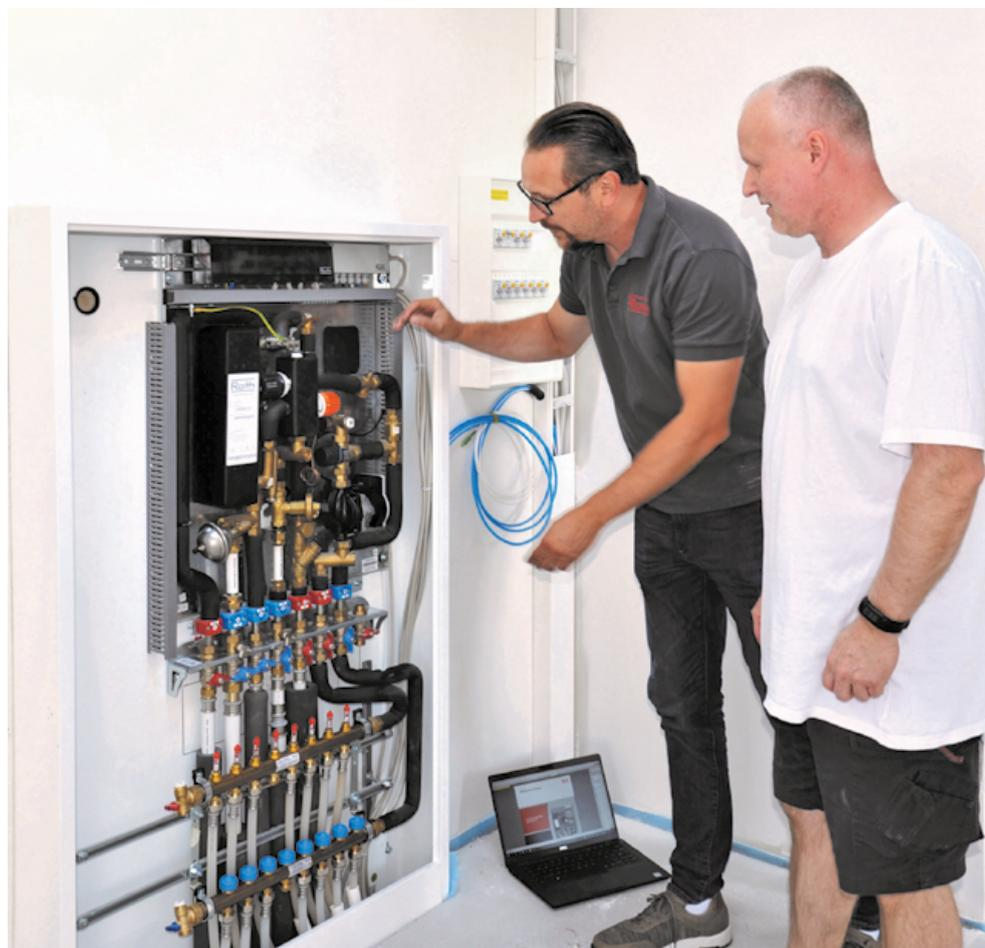
**Bild 2 • Von links: Manuel Kühnert von Roth mit SHK-Fachhandwerker Kai Wichelmann bei der Einstellung der Roth Wohnungsstationen FlatConnect. (Foto: Kathrin Bühring)**
